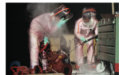
afbeelding 21 ► De radioactieve stoffen worden met water van de materialen afgespoeld.
